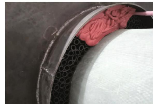
**Шаг 3:** оба конца монтажной рамы заполните слоем герметика Antifire firestop sealant не менее 15 мм.
