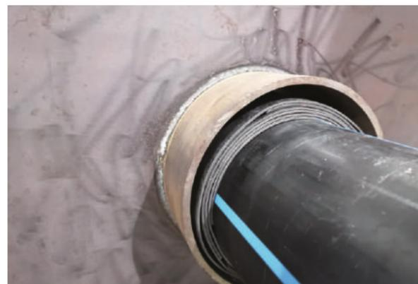
**Шаг 2:** используйте мат НК-S для заполнения пространства между трубой и монтажной рамой.
