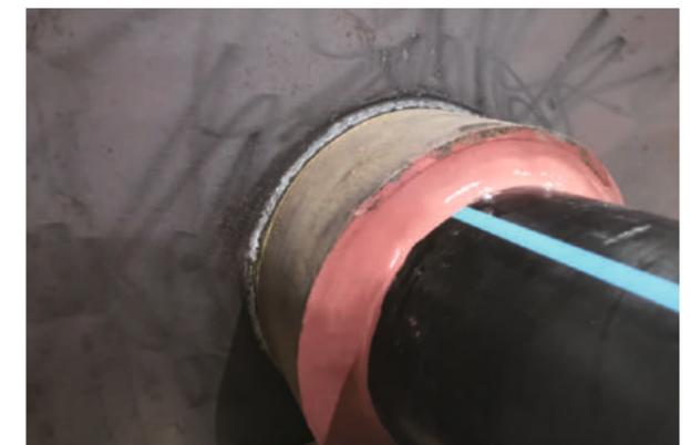
**Шаг 4:** прижмите и разгладьте влажной тканью верхний слой герметика с обоих концов монтажной рамы.
