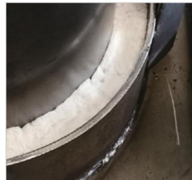
**Шаг 3:** оба конца монтажной рамы заполните слоем расширяющегося герметика НК-М не менее 20 мм.
