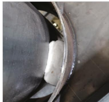
**Шаг 2:** используйте мат НК-В для заполнения пространства между трубой и монтажной рамой.
