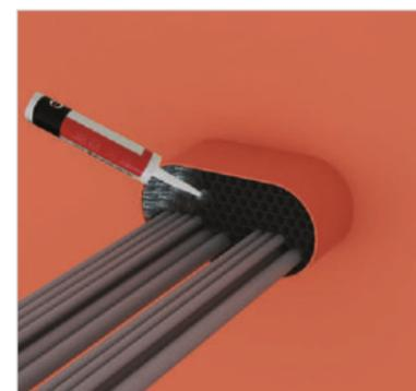
**Шаг 4:** оба конца кабельного прохода заполнить расширяющимся герметиком НК-M слоем не менее 20 мм.
