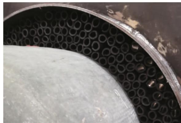
**Шаг 2:** с обоих концов монтажной рамой оставьте не менее 15мм для заполнения герметиком.
