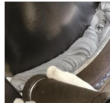
**Шаг 4:** пространство между трубой и стальной монтажной рамой необходимо заполнить герметиком с обоих концов монтажной рамы.
