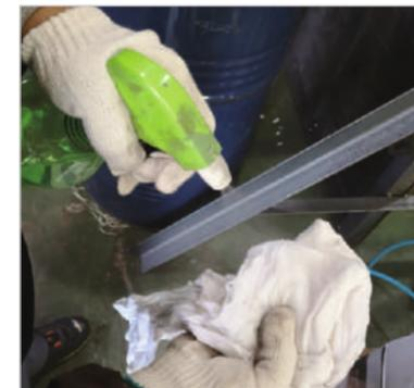
**Шаг 5:** прижмите и разгладьте влажную тканью верхний слой герметика.
