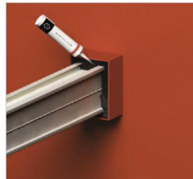
**Шаг 3:** используйте НК-M – герметик расширяющийся огнестойкий для герметизации двух концов проходки, толщина наносимого слоя 15 мм.
